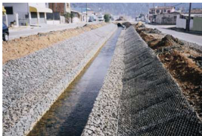
Durante a obra
