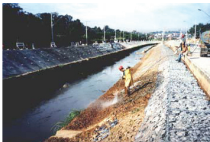
Durante a obra
