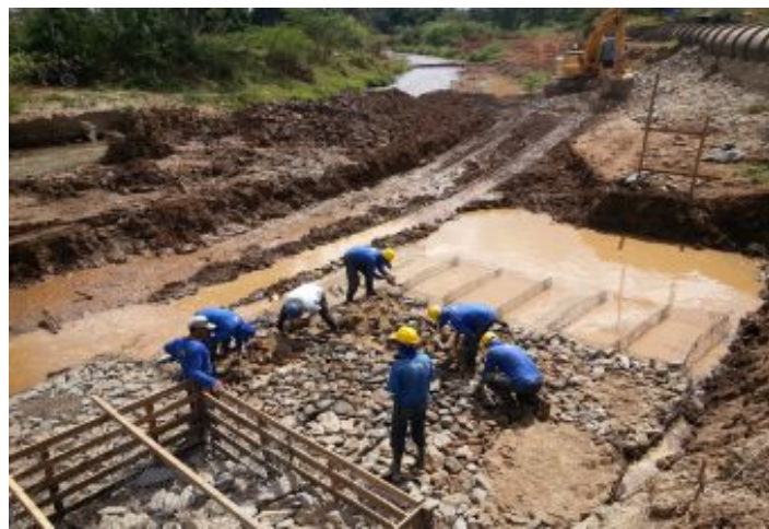
Durante a obra
