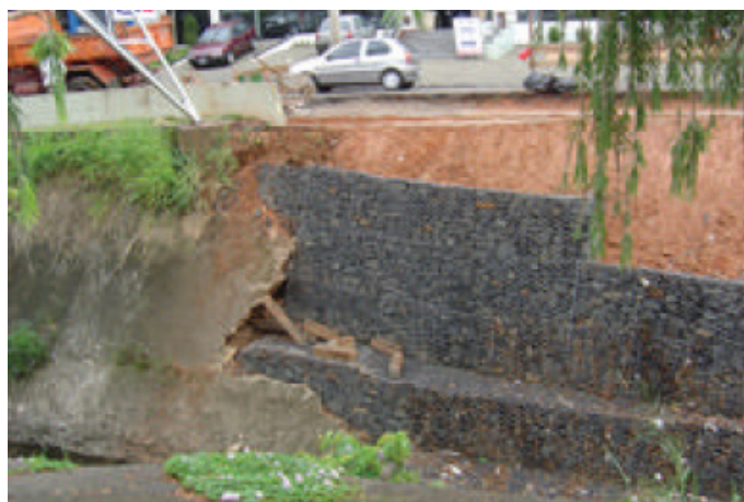
Durante a obra
