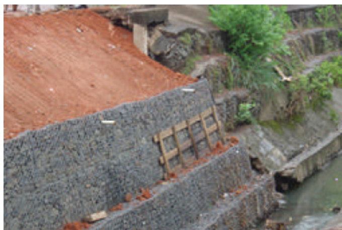
Durante a obra
