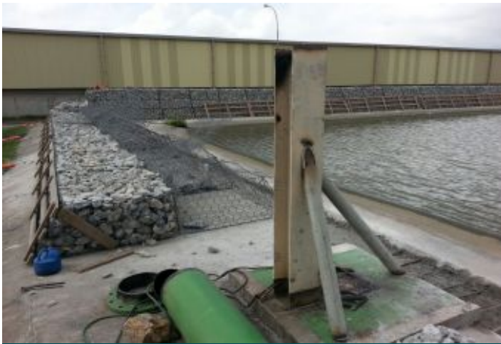
Durante a obra
