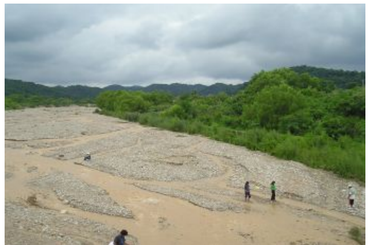
Durante a obra
