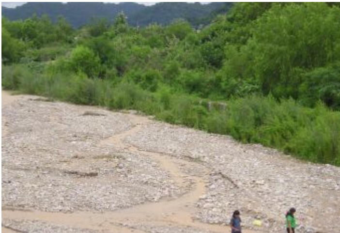
Durante a obra
