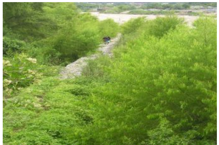
Durante a obra
