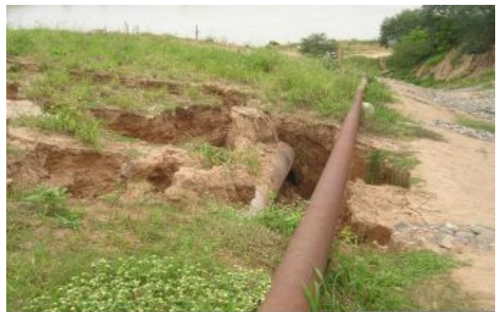
Durante a obra
