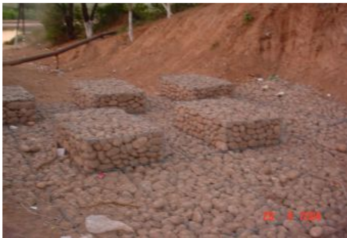
Durante a obra
