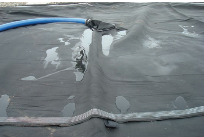
Durante a Obra
