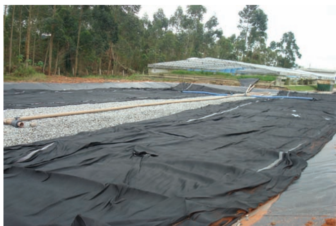
Durante a Obra
