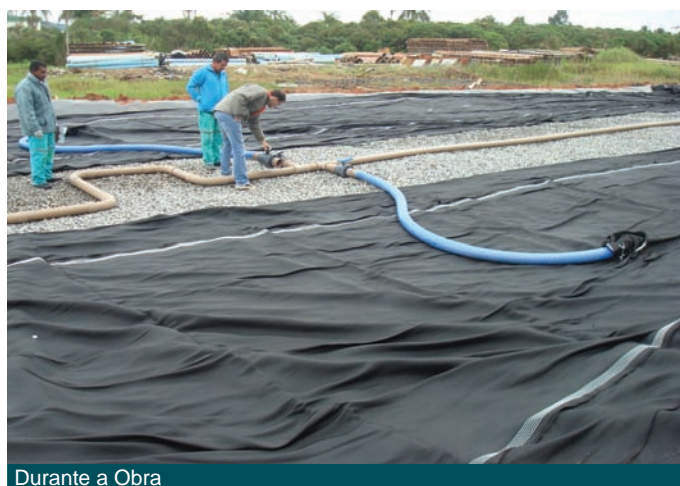
Durante a Obra
