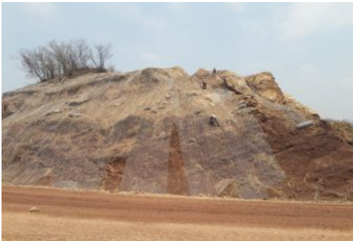
Durante la Obra
