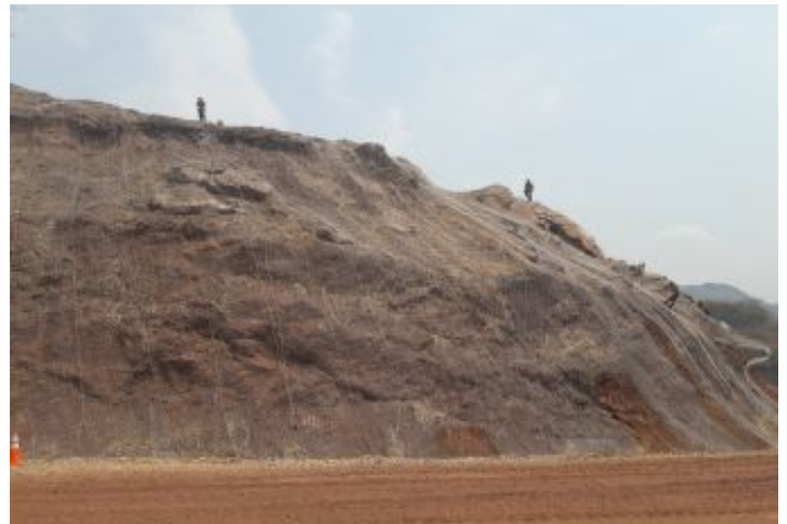
Durante la Obra
