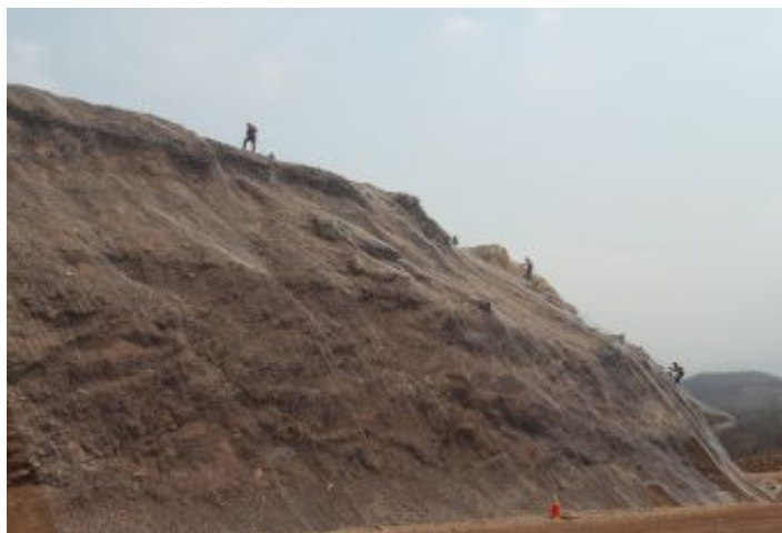
Durante la Obra
