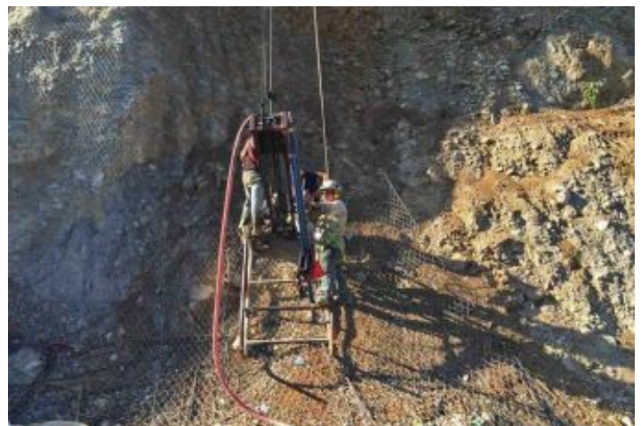
Durante la Obra
