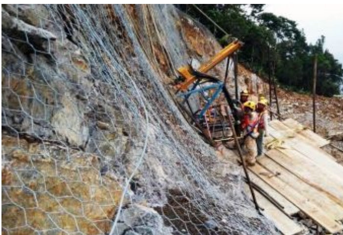
Durante la Obra
