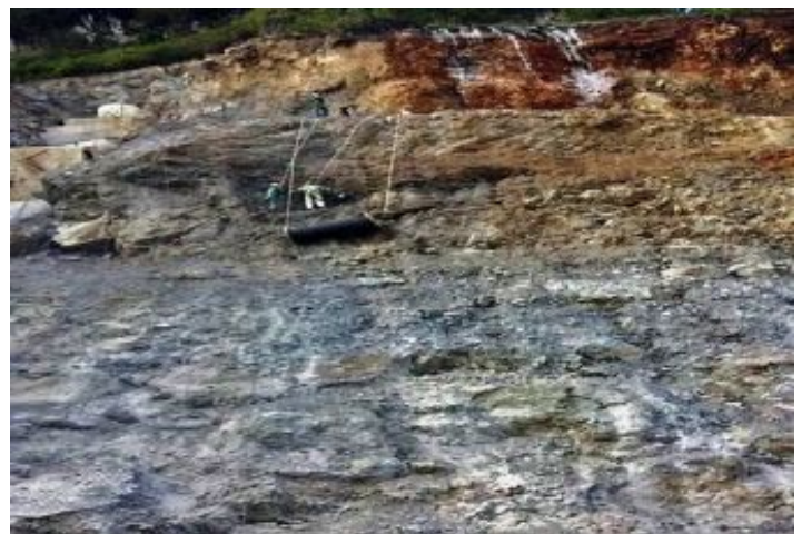
Durante la Obra
