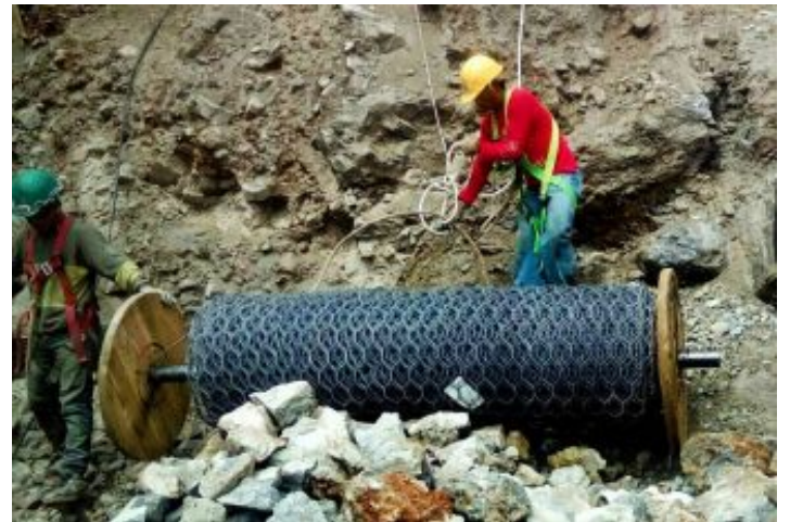
Durante la Obra
