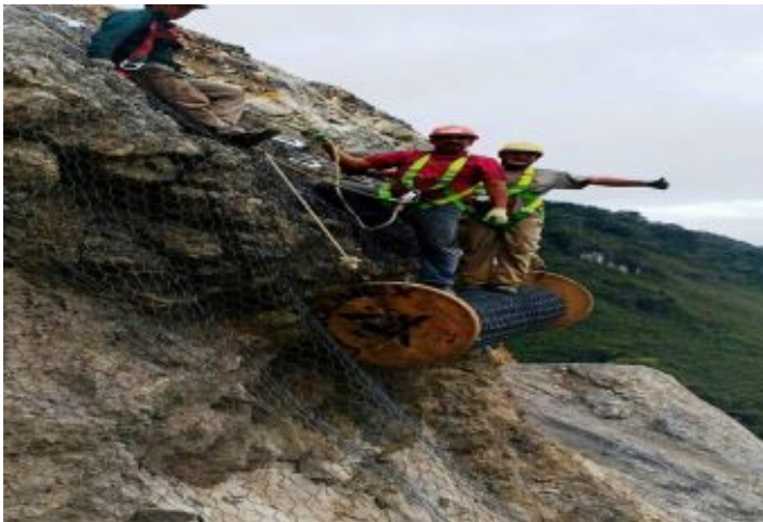
Durante la Obra
