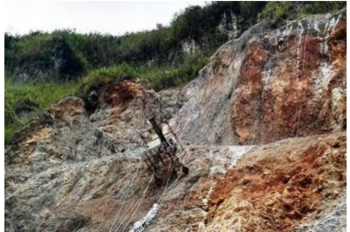
Durante la Obra
