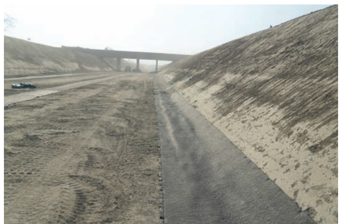
Durante la obra
