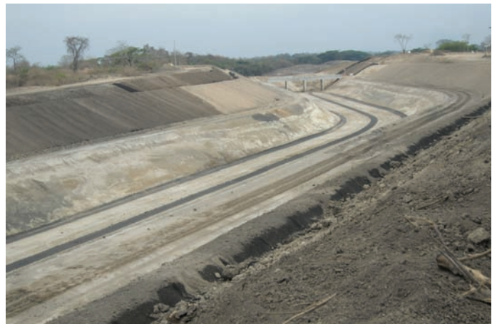
Durante la Obra
