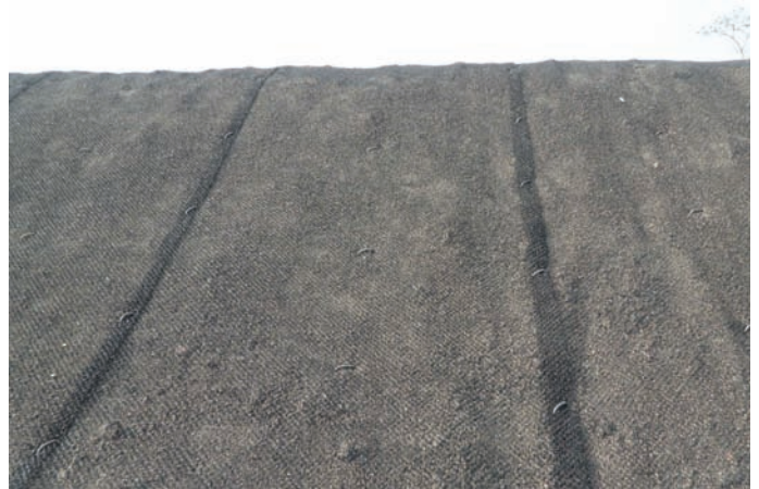
Durante la Obra
