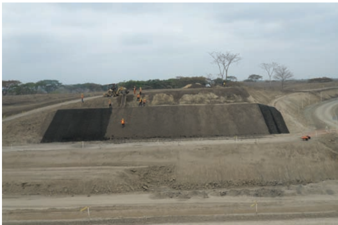
Durante la Obra
