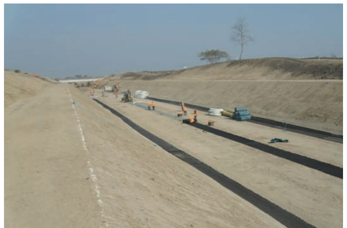
Durante la Obra
