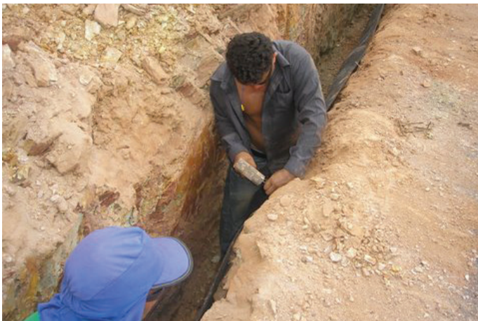
Durante la obra
