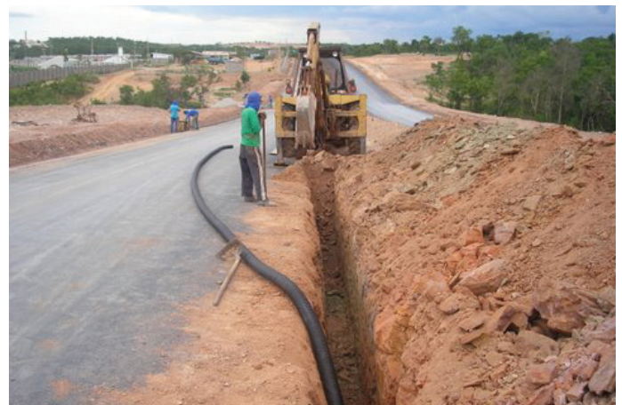
Durante la obra
