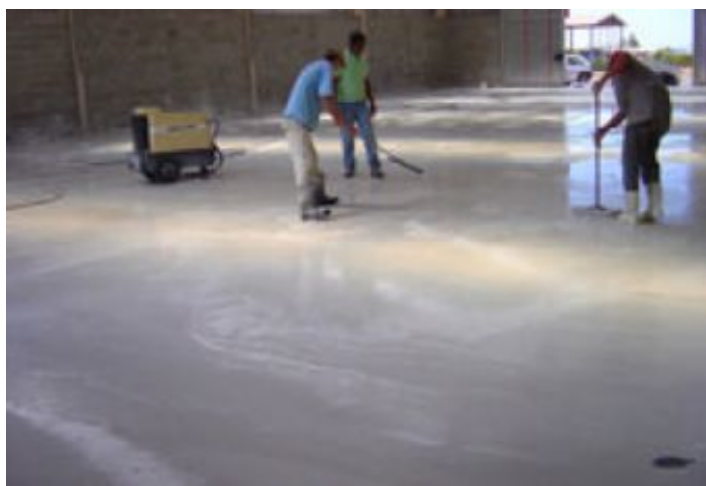
Durante a obra
