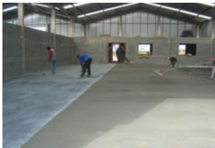
Durante a obra
