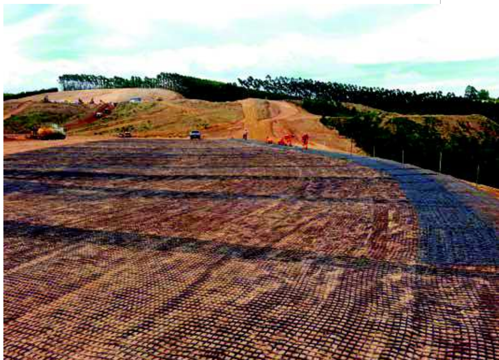
▲ Volumes de terraplenagem chegaram a 200 mil metros cúbicos de terra
