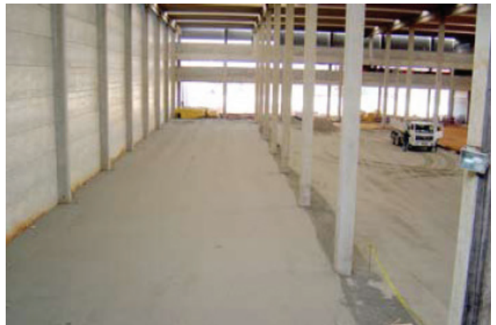
Durante a obra
