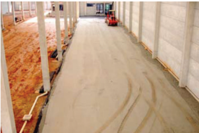
Durante a obra
