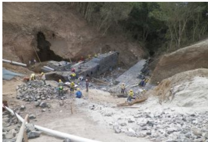
Durante a obra
