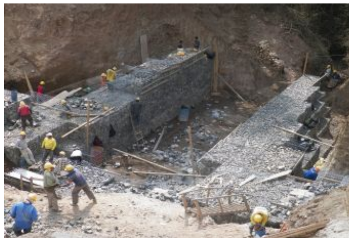
Durante a obra
