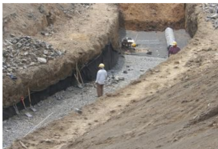
Durante a obra
