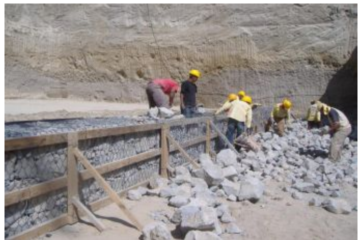
Durante a obra
