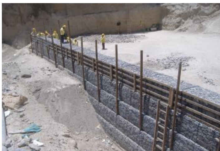
Durante a obra
