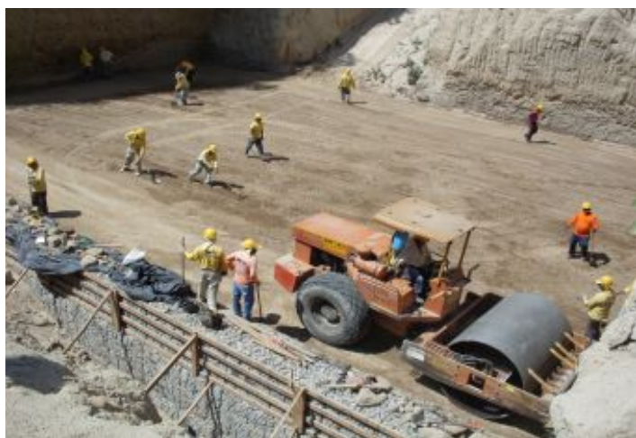
Durante a obra
