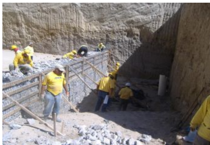
Durante a obra
