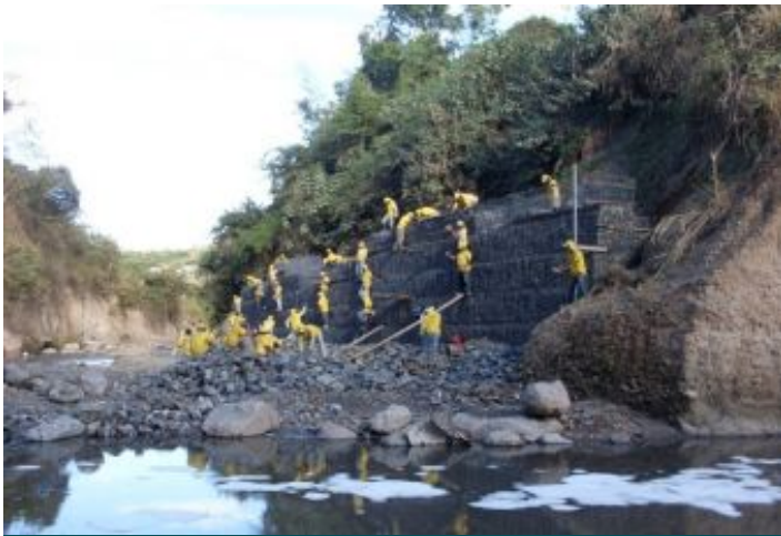
Durante a obra
