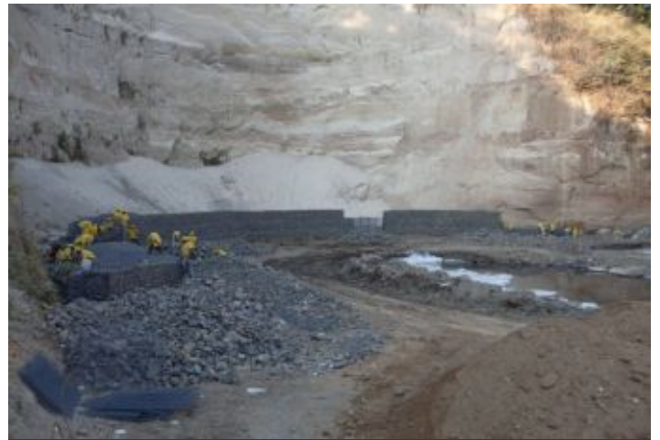
Durante a obra
