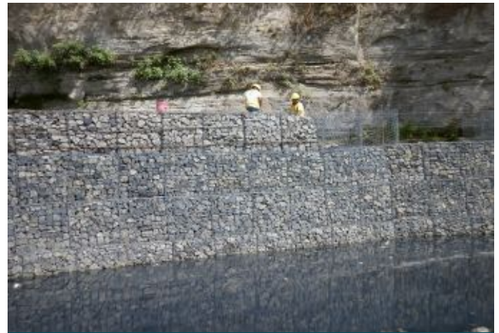
Durante a obra
