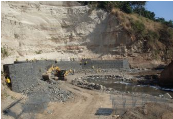
Durante a obra
