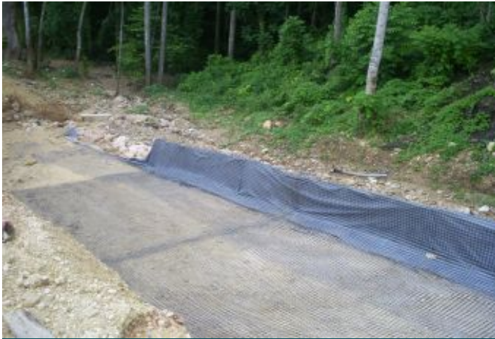
Durante a obra
