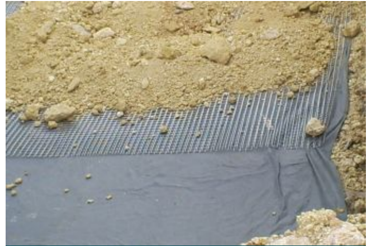
Durante a obra
