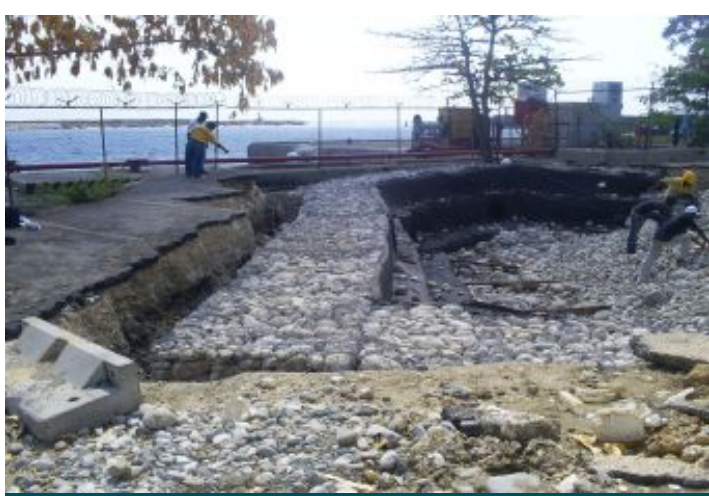
Durante a obra
