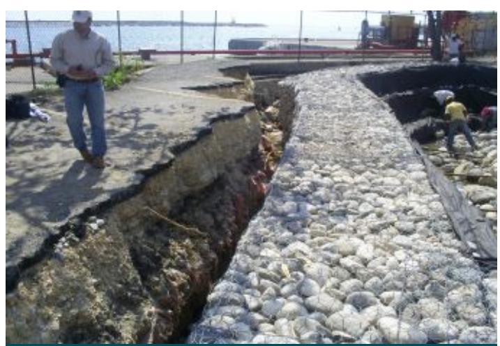
Durante a obra
