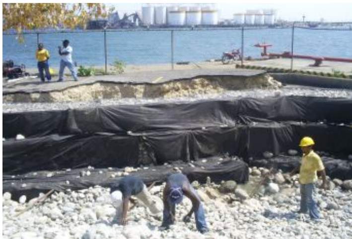
Durante a obra
