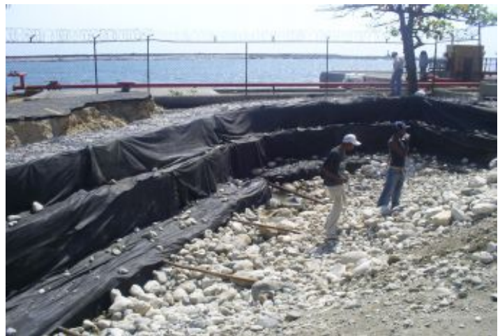
Durante a obra
