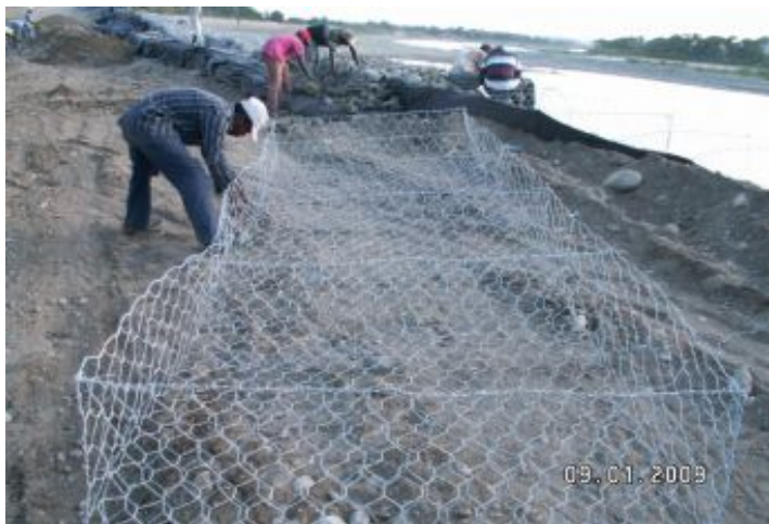
Durante a obra
