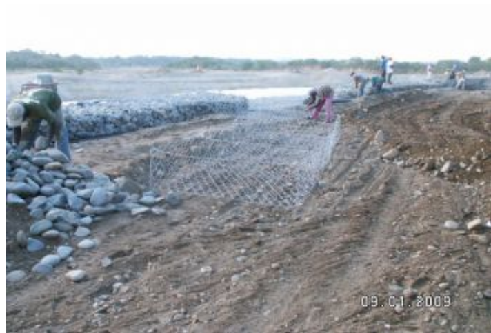
Durante a obra
