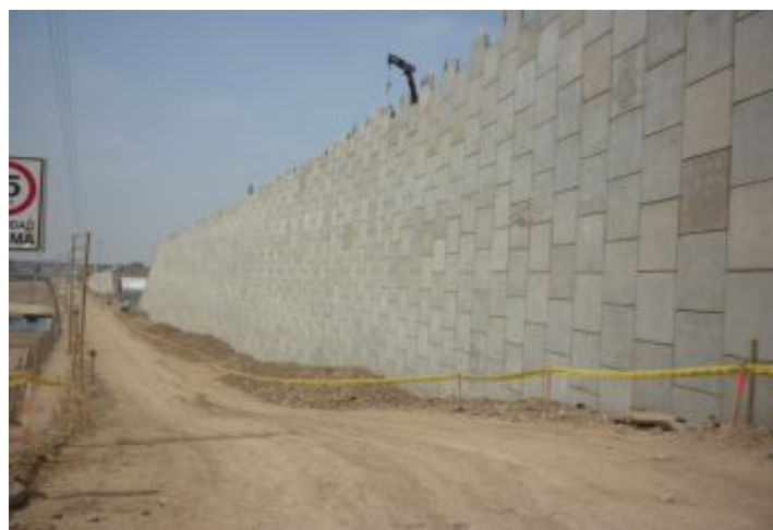
Durante a obra
