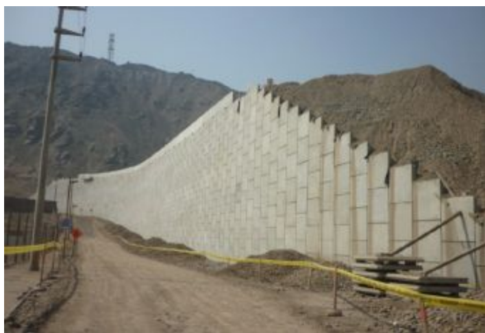
Durante a obra
