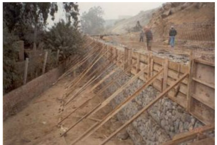
Durante a obra
