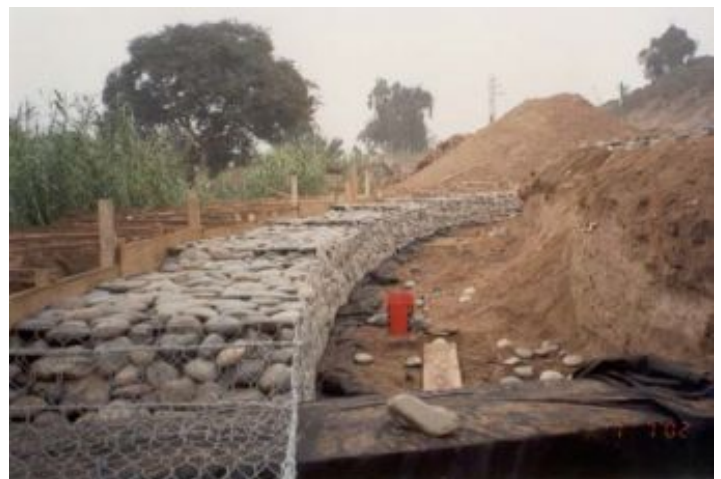
Durante a obra
