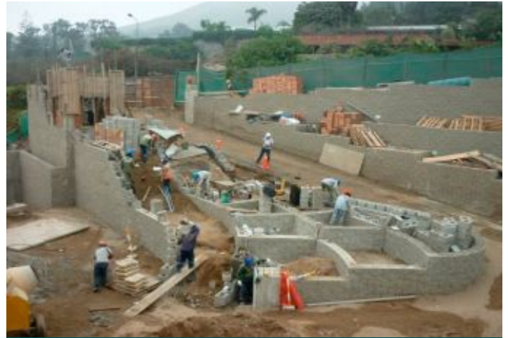
Durante a obra
