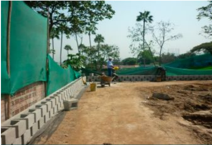
Durante a obra
