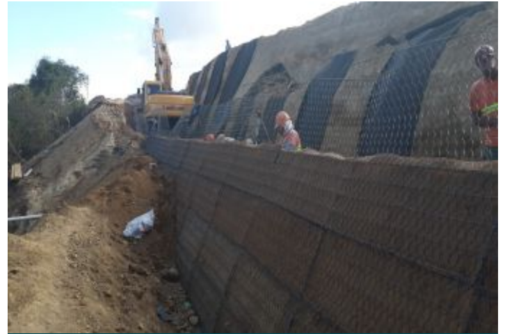
Durante a obra
