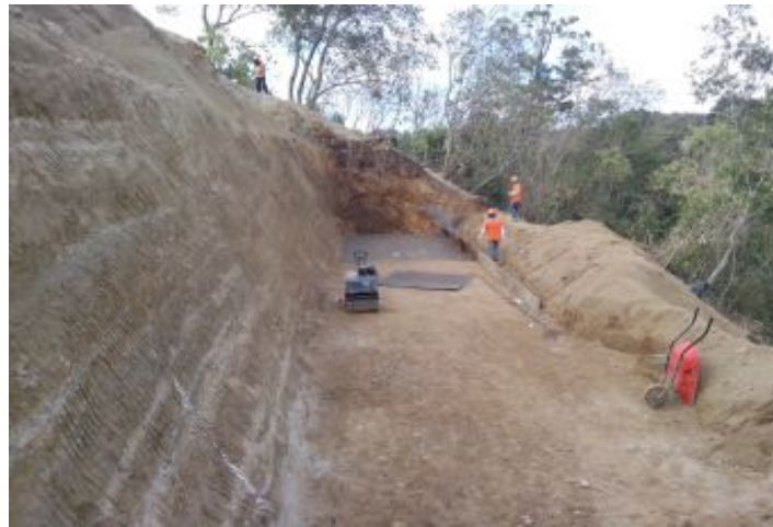
Durante a obra
