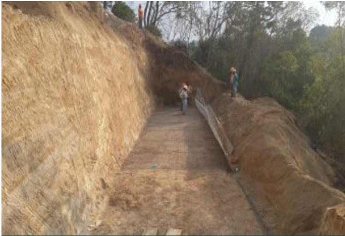
Durante a obra
