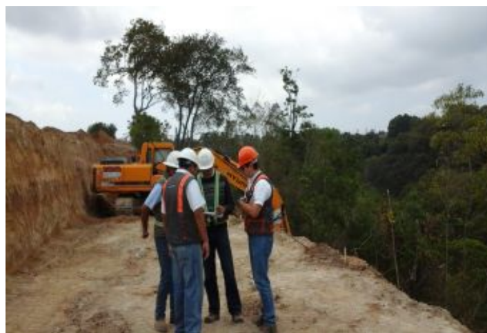
Durante a obra
