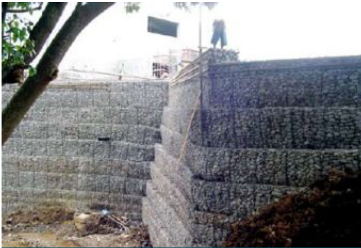
Durante a obra
