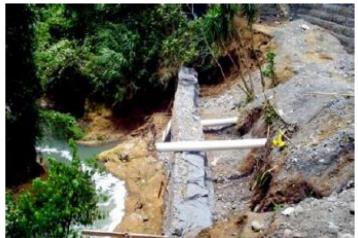
Durante a obra
