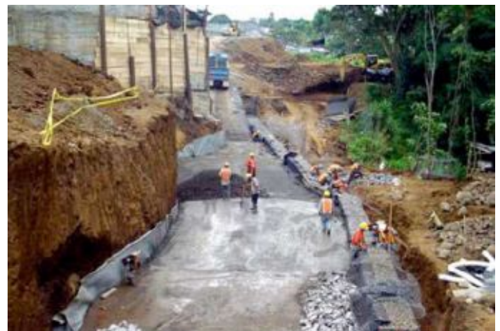
Durante a obra
