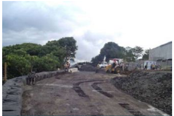
Durante a obra
