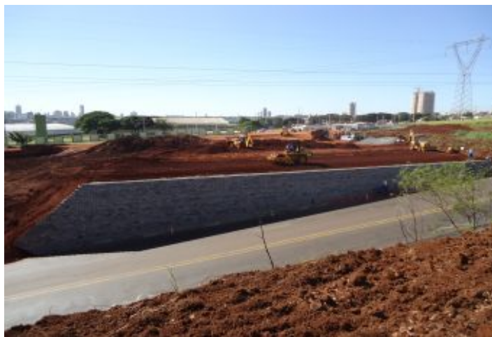
Durante a obra
