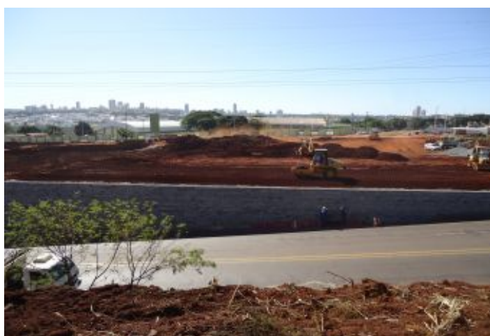
Durante a obra
