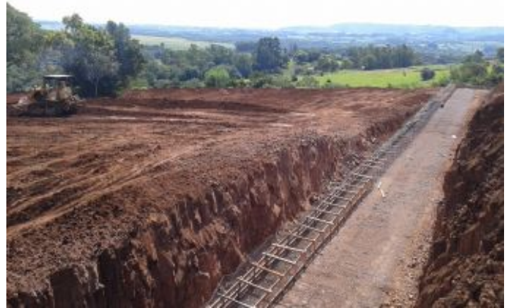
Durante a obra
