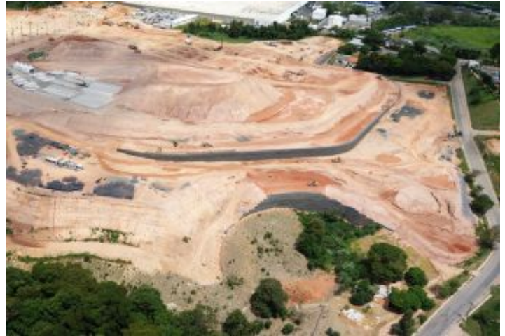
Durante a obra
