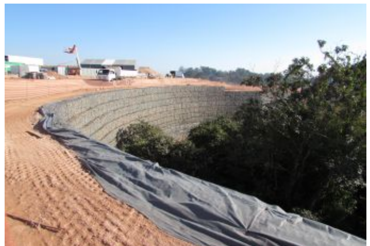
Durante a obra
