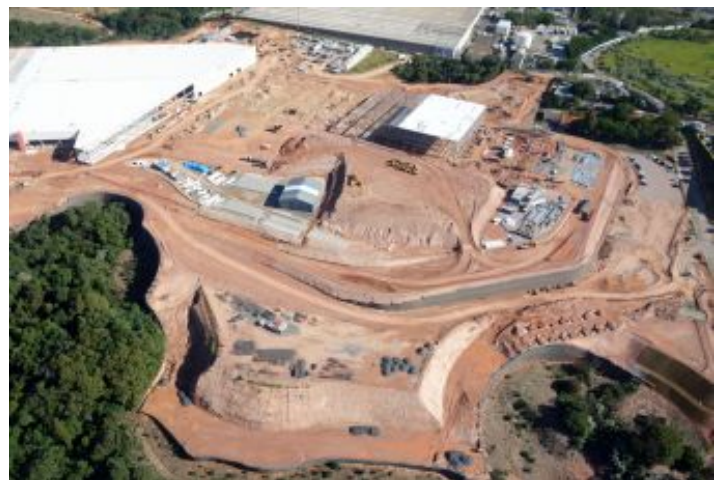
Durante a obra
