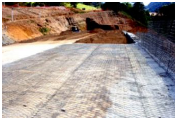
Durante a obra
