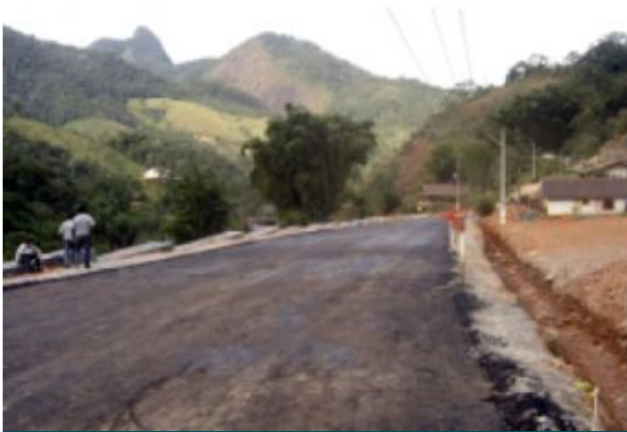
Durante a obra
