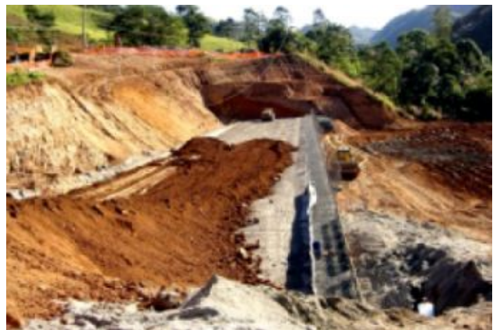
Durante a obra
