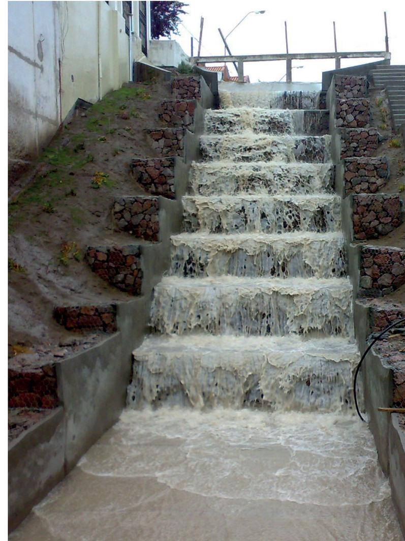
Obras de canalização e escada dissipadora expostas a grande fluxo de água e raios UV
