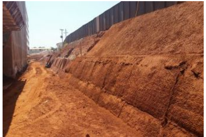
Durante a obra
