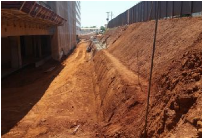
Durante a obra
