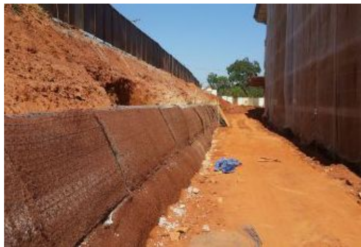
Durante a obra
