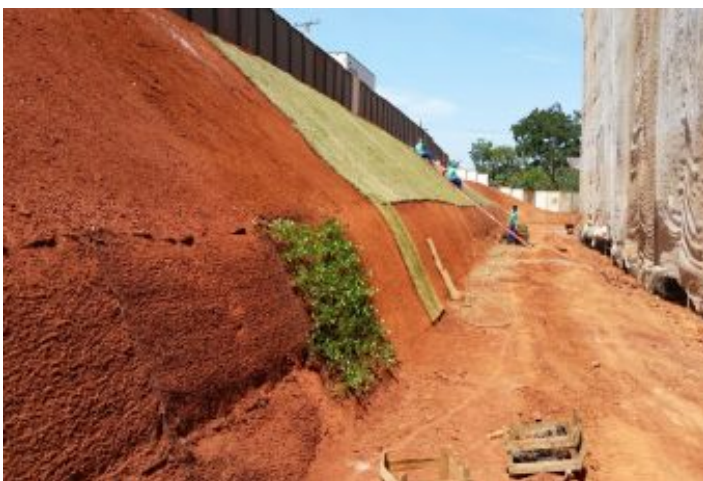
Durante a obra
