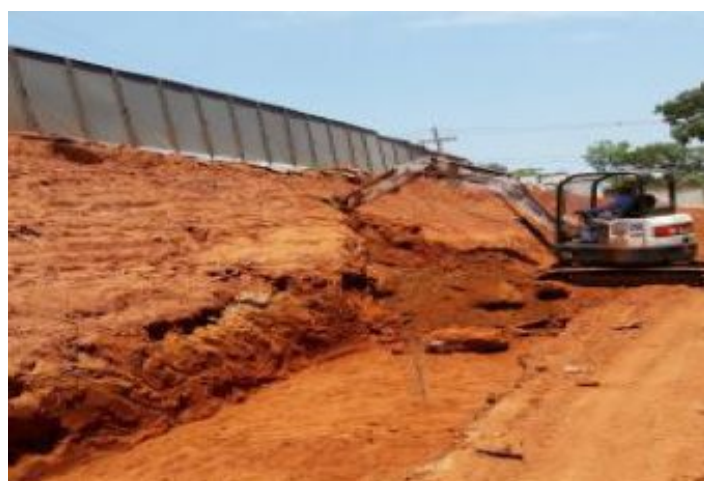
Durante a obra
