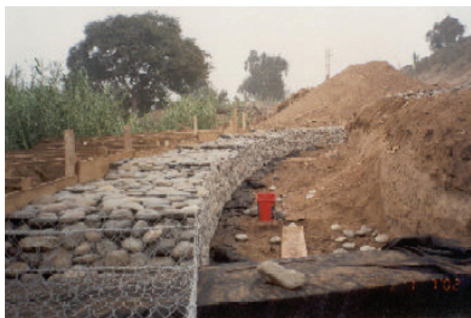
Durante a obra
