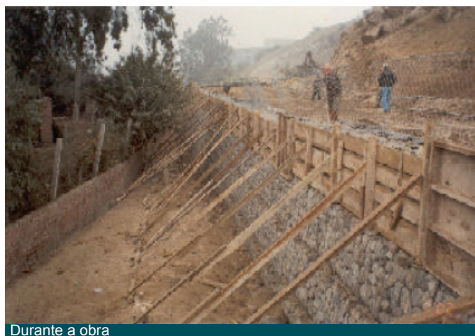
Durante a obra
