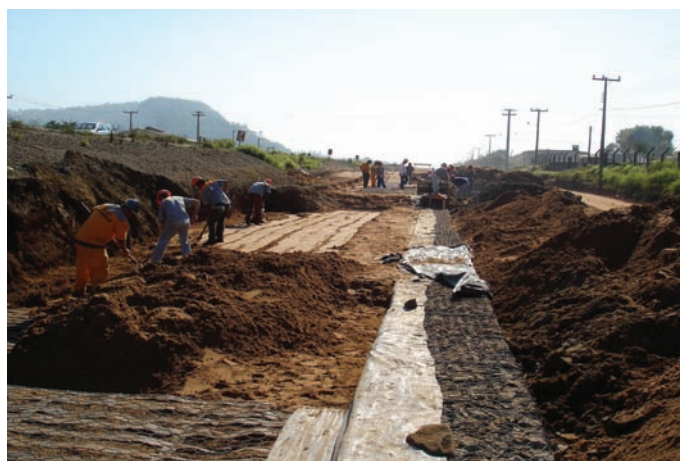
Durante a obra
