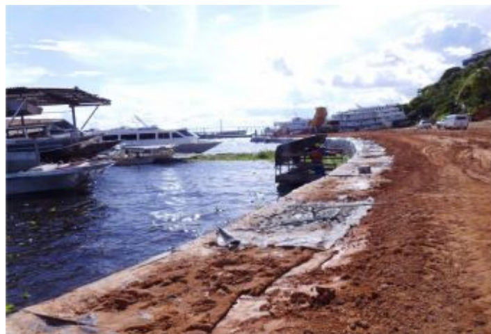
Durante a obra
