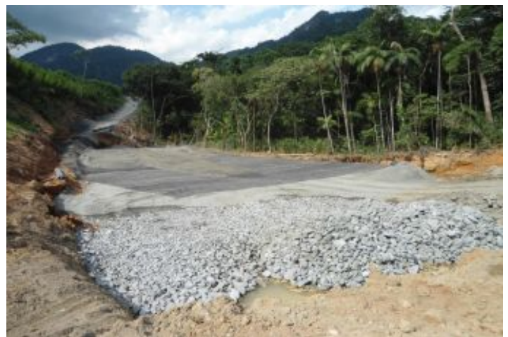
Durante a obra
