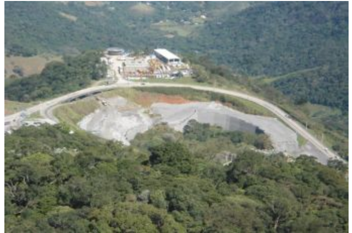
Durante a obra
