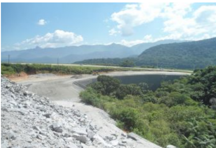
Durante a obra
