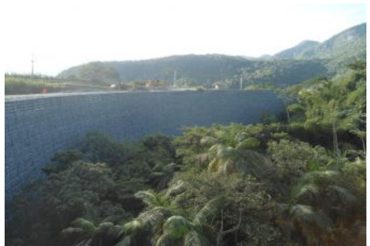
Durante a obra
