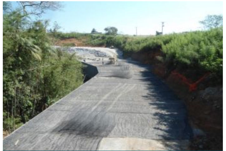
Durante a obra
