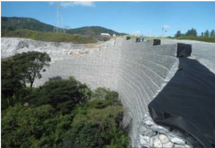
Durante a obra
