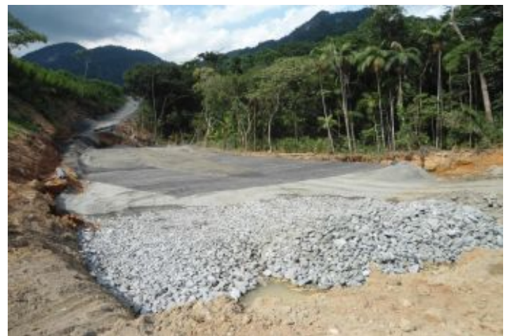
Durante a obra
