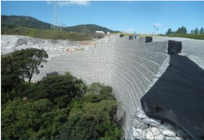
Durante a obra
