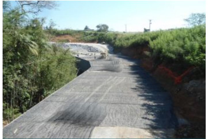
Durante a obra
