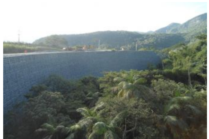
Durante a obra
