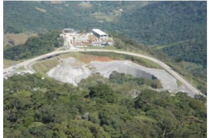
Durante a obra
