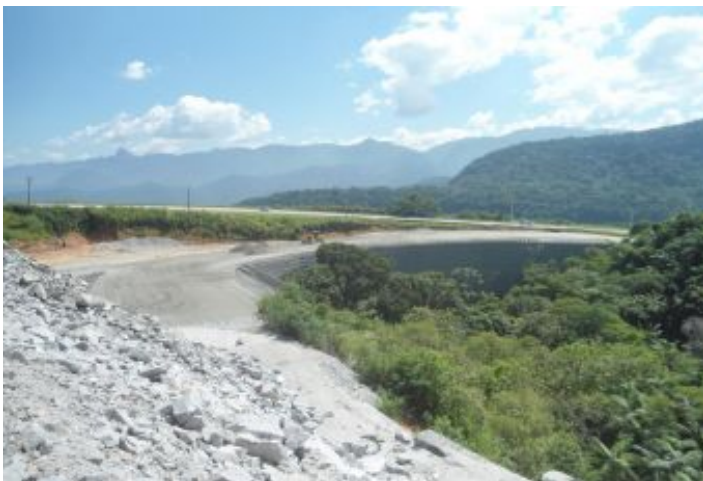
Durante a obra
