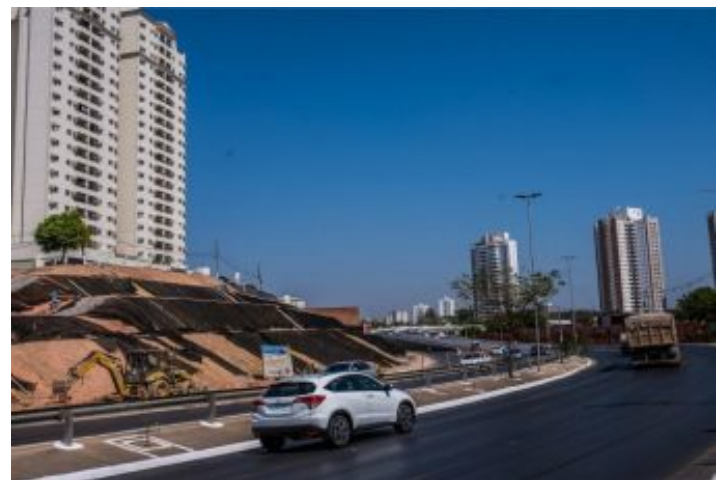
Durante a obra
