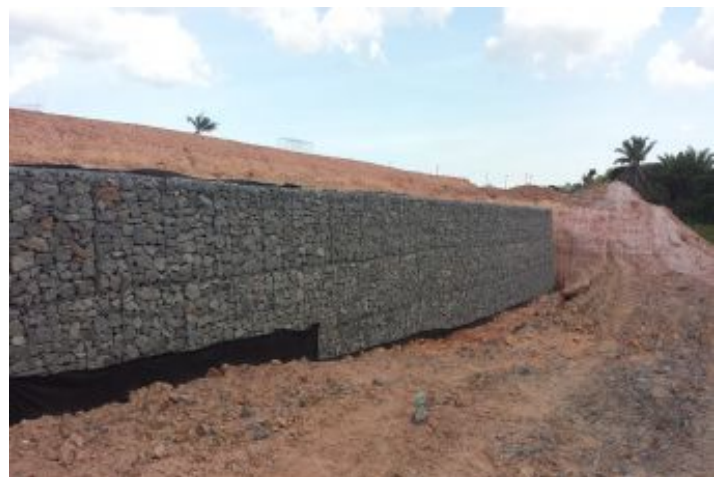
Durante a obra
