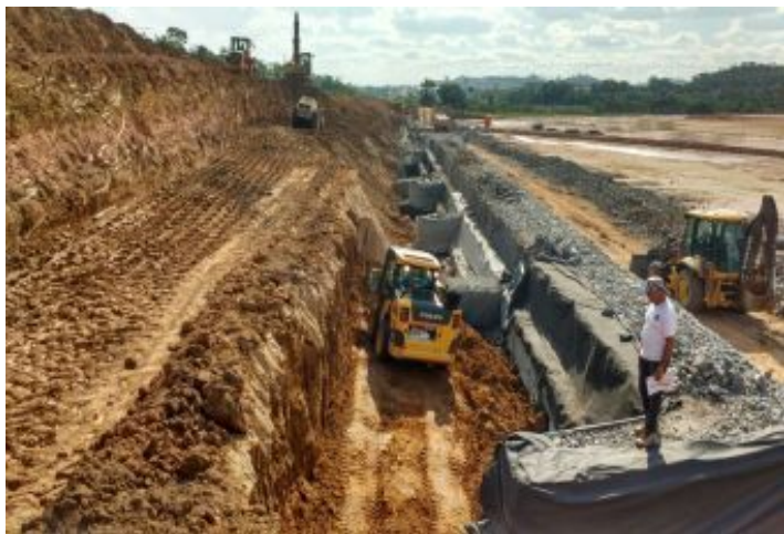
Durante a obra
