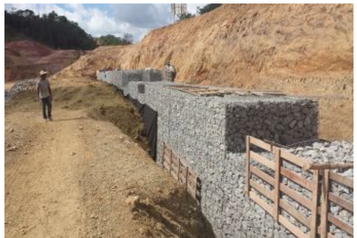
Durante a obra
