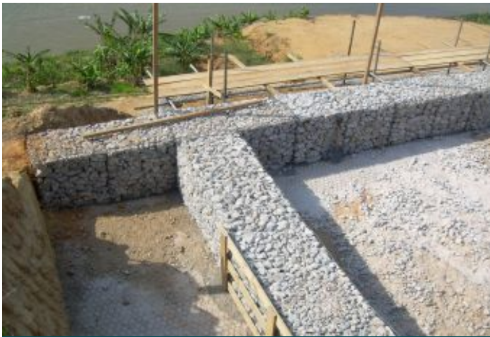
Durante a obra
