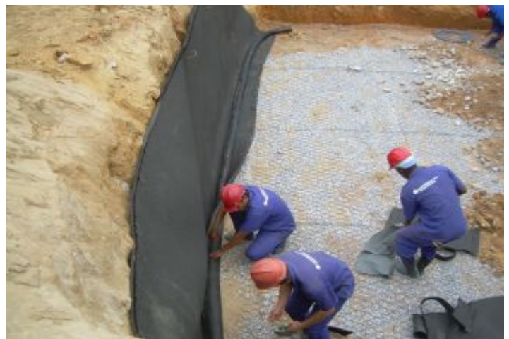
Durante a obra
