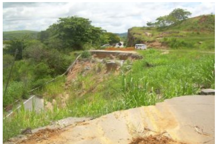
Durante a obra
