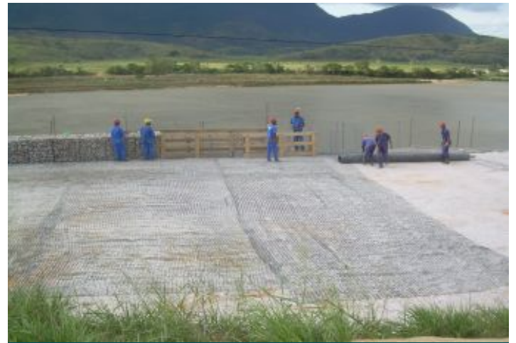
Durante a obra
