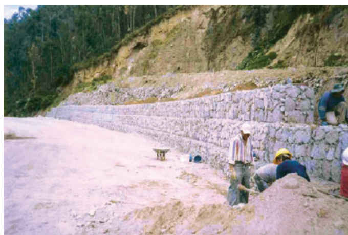
Durante a obra
