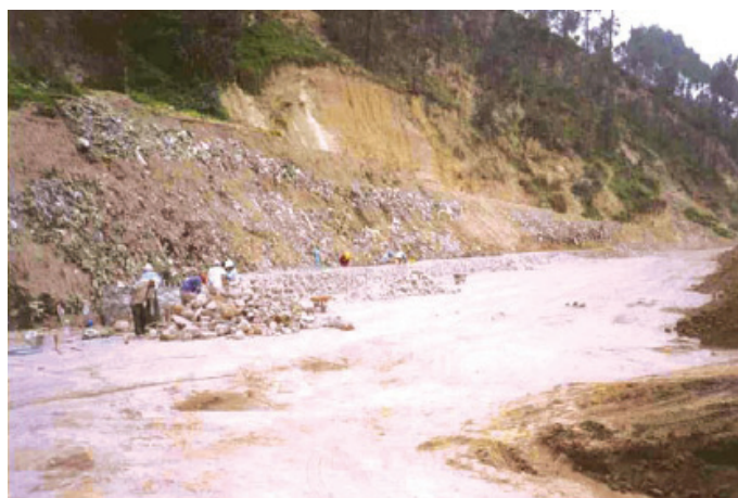
Durante a obra
