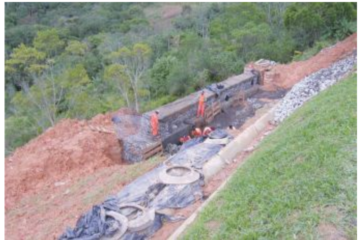
Durante a obra
