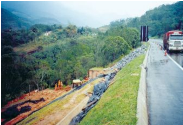
Durante a obra
