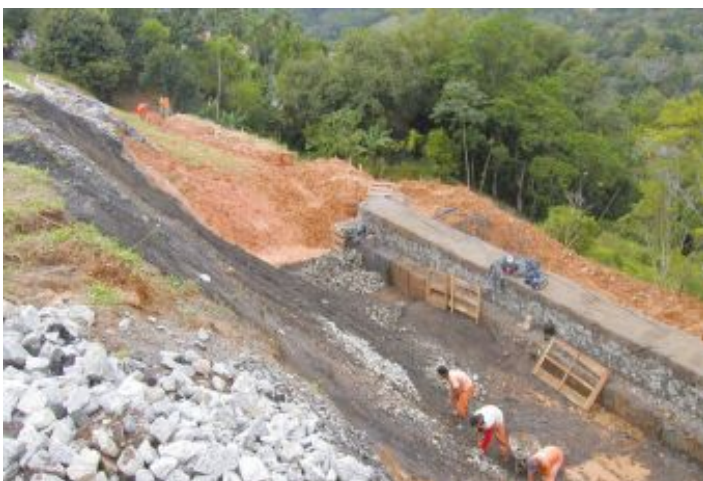
Durante a obra
