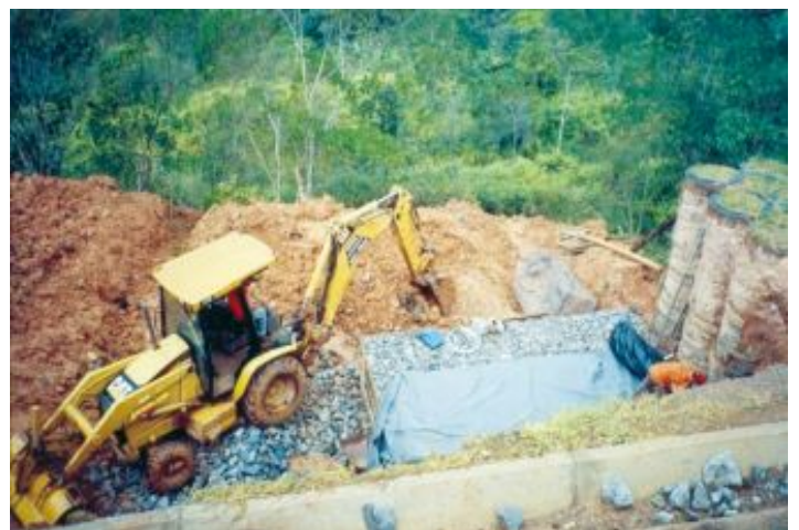
Durante a obra
