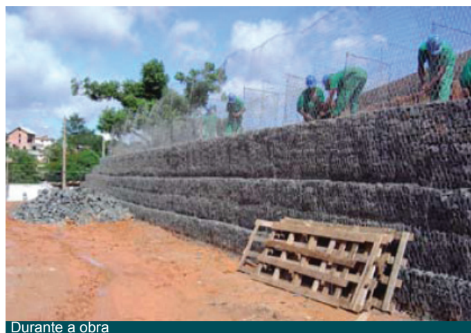
Durante a obra
