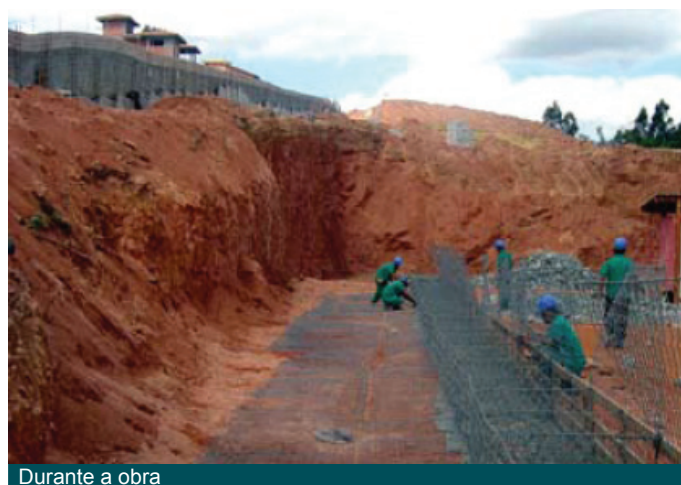
Durante a obra
