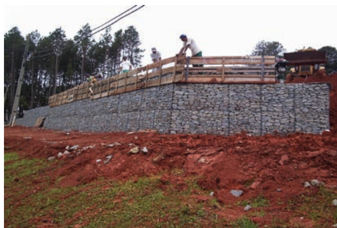
Durante a obra
