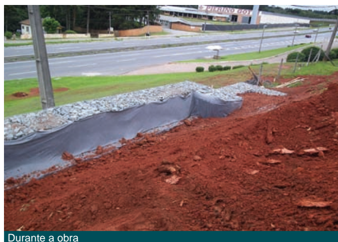
Durante a obra
