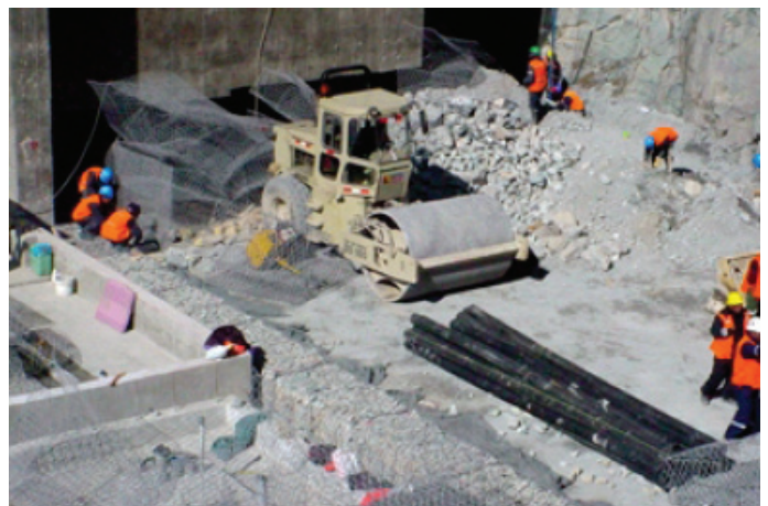
Durante a obra
