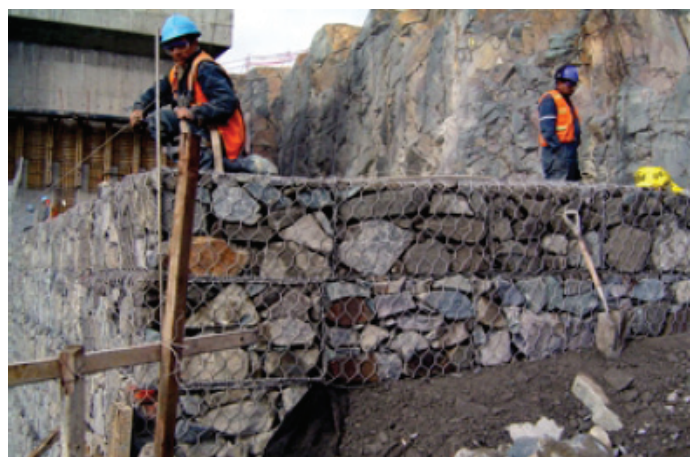
Durante a obra
