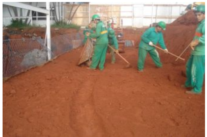
Durante a obra
