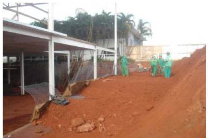
Durante a obra
