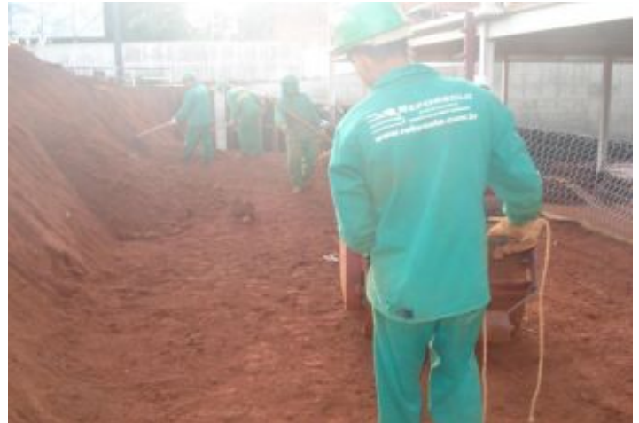
Durante a obra
