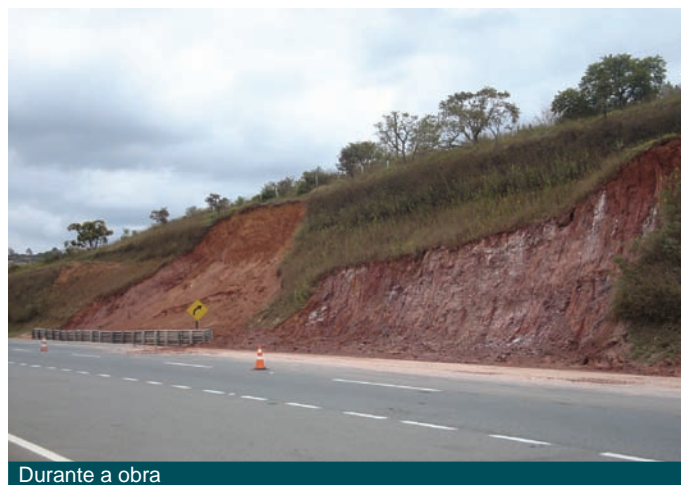
Durante a obra
