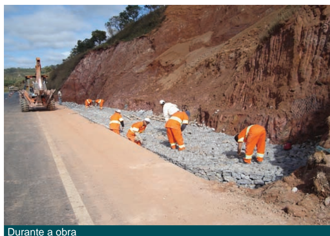
Durante a obra
