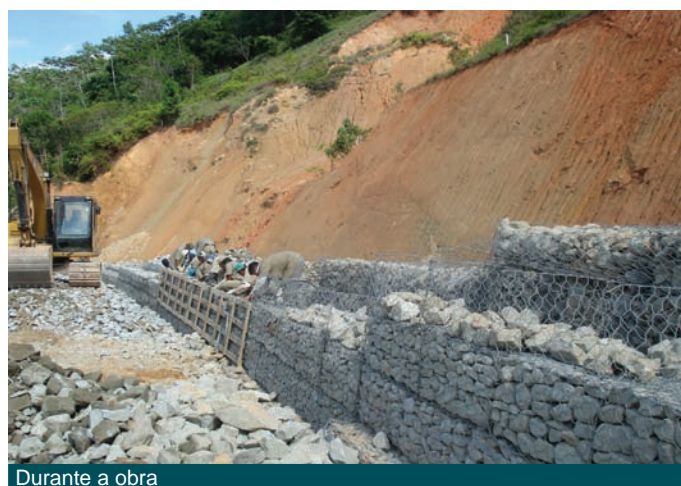
Durante a obra
