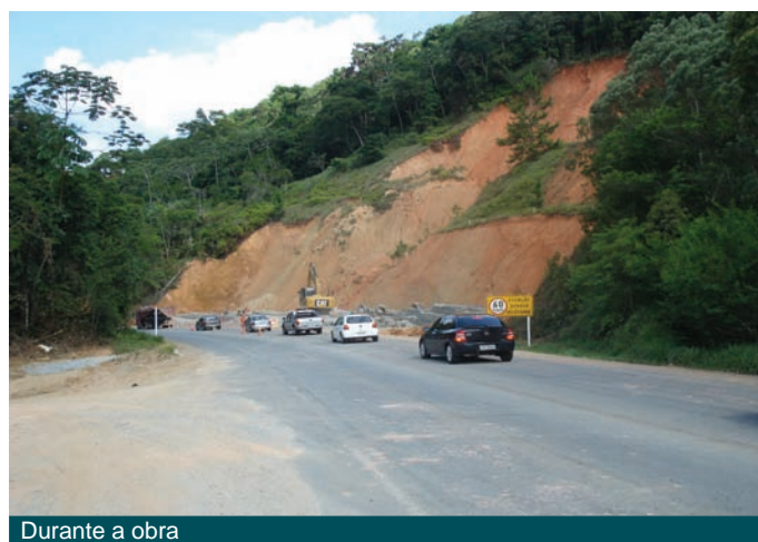
Durante a obra
