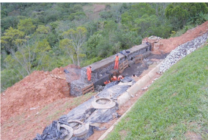
Durante a Obra
