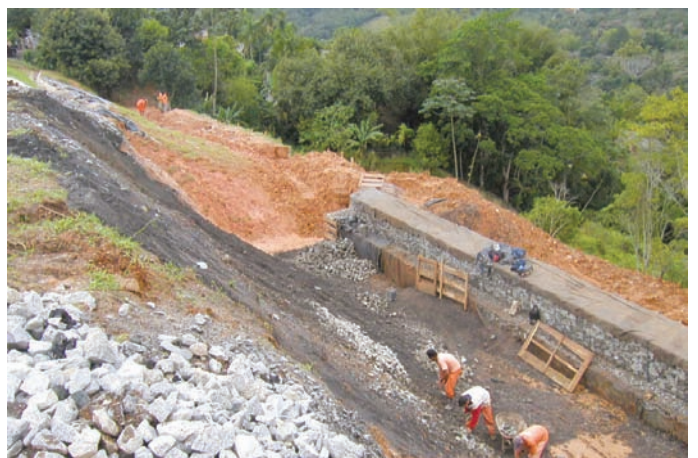
Durante a Obra
