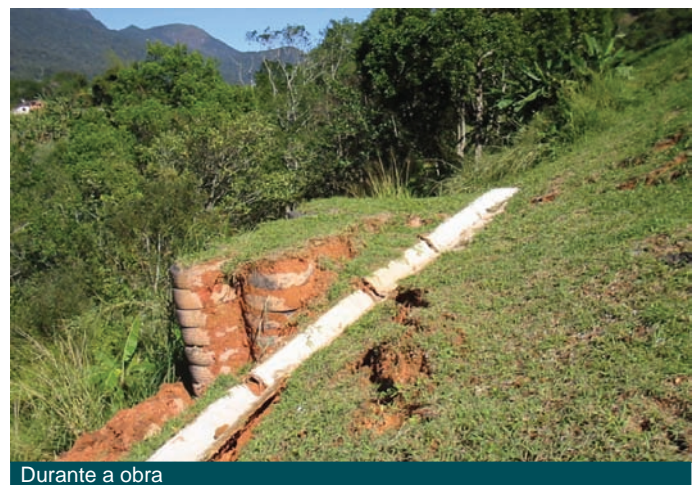
Durante a obra
