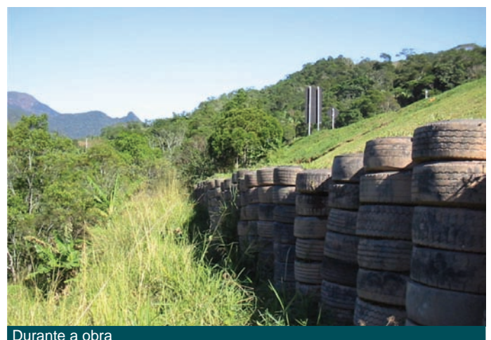
Durante a obra
