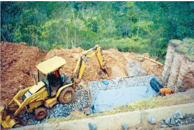
Durante a obra
