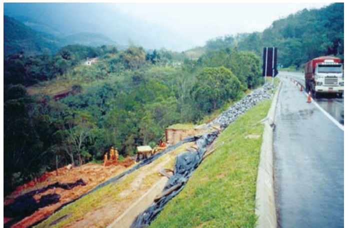
Durante a obra
