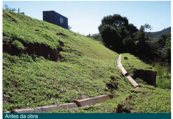
Antes da obra
