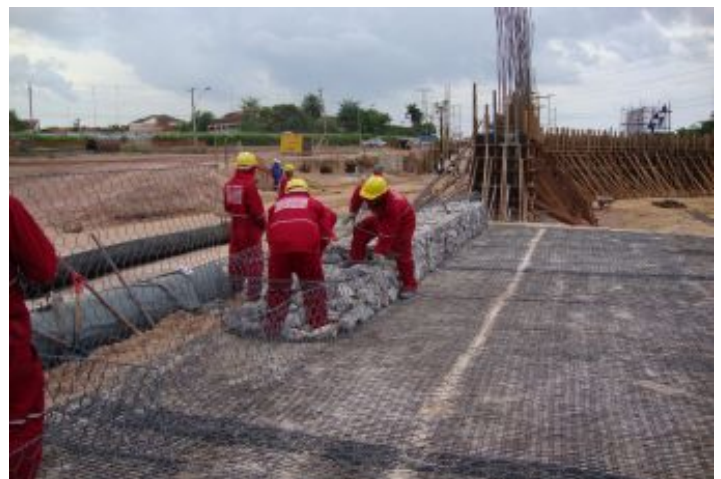
Durante a obra
