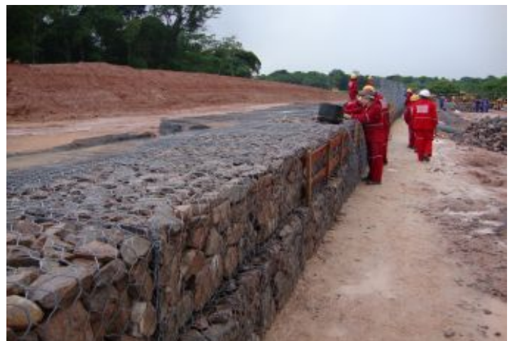
Durante a obra
